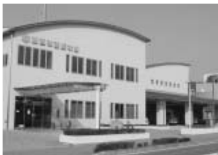
加西市消防本部
