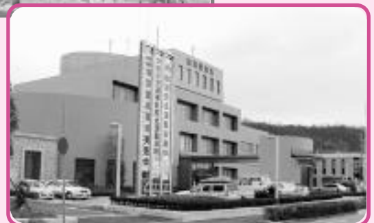
加西警察署新庁舎完成
