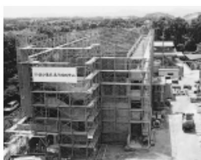
↑ 急ピッチで建設が進む東高室鉄筋住宅
