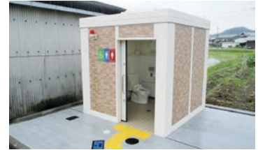
公衆トイレを多目的トイレに改築南側利用者用駐り場も併せて整備
