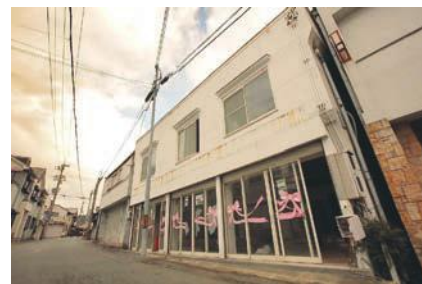
空き店舗だった「暮しのファッションやまもと」をゲストハウスとして改修
