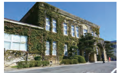
長島愛生園歴史館（旧事務本館）
