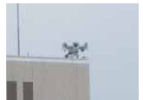
音達距離1.8kmの消防防災サイレン
