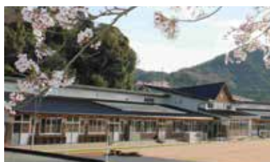
改築工事を行った西在田小学校
