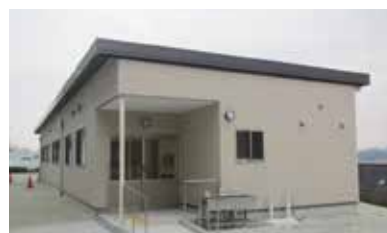
北条東小学校内に建設の学童保育専用棟
