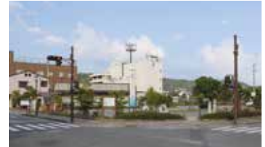
建設予定地の市営駐車場
