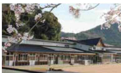
改築工事を行った西在田小学校
