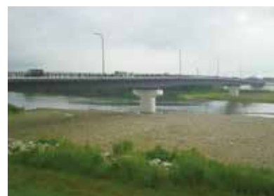
開通した栗田橋
