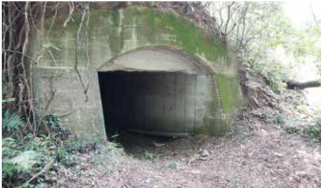
壁厚は約1mで、前面に爆風避けの土堤が設けられている爆弾庫
