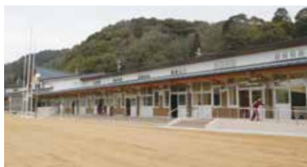
完成した新校舎（総事業費は約7億円）
