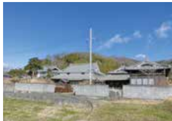
谷町にある空き家
