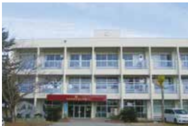
耐震補強を行った九会小学校の南校舎
