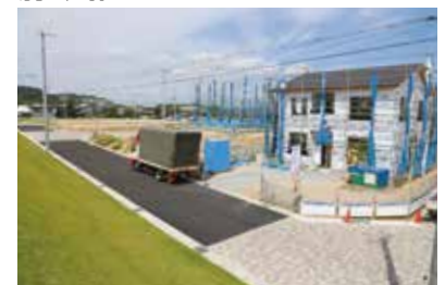
旧下里小学校跡地に 28 区画を造成
