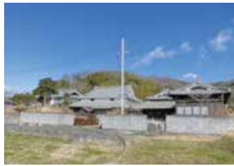
谷町にある空き家
