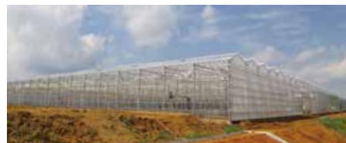
建設が進む次世代施設園芸モデル団地
