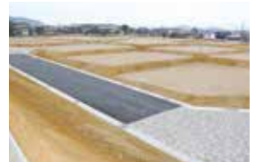
インターロッキング舗装などの道路整備がされた販売区画
