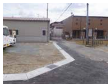
拡幅工事を実施した道路
