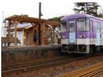
平成24年12月に新設された田原駅のトイレ(屋根瓦の建物)
