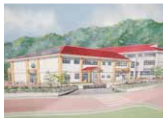
富田小新校舎は平成27年7月完成予定
