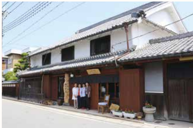
▲大正 11 年に建てられた水田家住宅。
