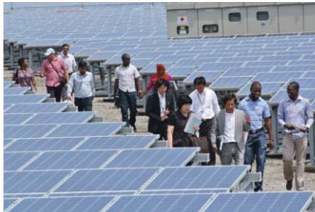
▲美樹工業(株)が建設した県内最大級の加西第1・第2メガソーラー発電所 (3.5MW) を見学する JICA 研修生。
