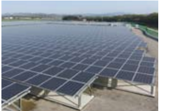
加西第1・第2メガソーラー発電所（豊倉町）
