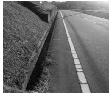
歩道が無く路肩も狭い（市道油谷1号線）。
