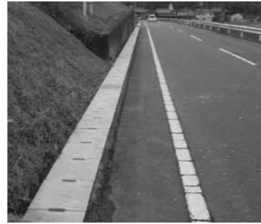
側溝に蓋掛けをして、路肩を拡幅しました。
