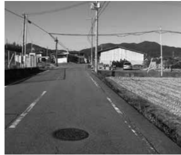
歩道が無く路肩も狭い。白線も消えかかっている（市道河内野上線）。
