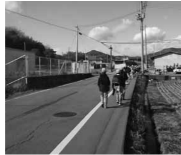
中央線を消し、路肩の幅を広げて外側線を引き直しました。路肩は緑色に着色し、通学路を確保しました。
