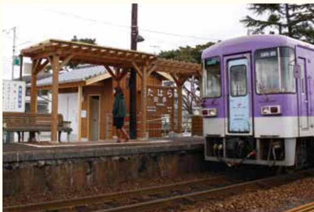
▲新設されたトイレ（屋根瓦のある建物）
