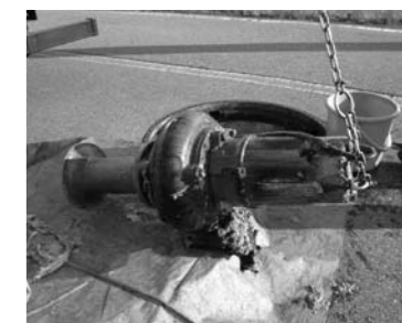
衣類や紙おむつなどが詰まって動かなくなったポンプ
