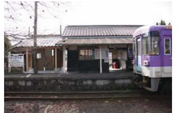
▲駅舎に隣接する水洗化、バリアフリー化された法華口のトイレ（左）。
