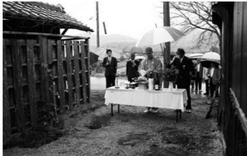
法華口駅での地鎮祭。駅の隣に建設予定。
