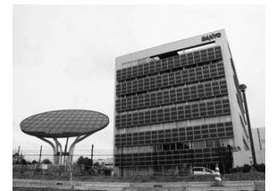
三洋電機加西グリーンエナジーパーク誘致
