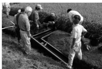
住民により設置される「水田魚道」
