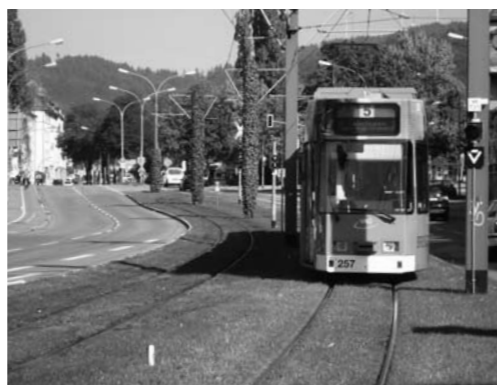
トラム（路面電車）の軌道には芝生が張られ、防音・景観・環境・ヒートアイランド対策に有効である。
