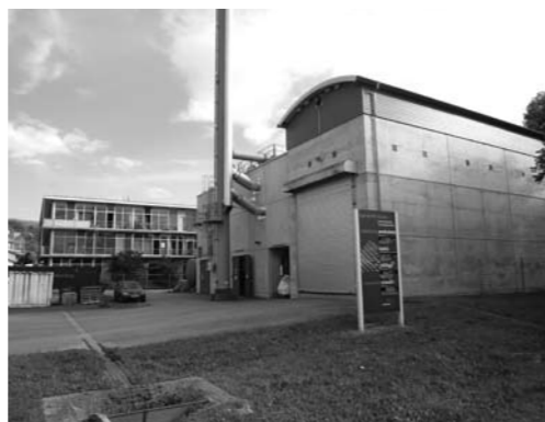
木質チップのバイオマス・コージェネレーションシステムにより、電気と熱が供給されている。うしろはエコハウス。
