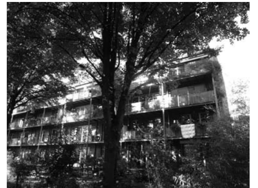
団地開発の際に樹齢60年以上の大木（菩提樹、プラタナスなど）を残したので、緑豊かで夏は涼しく冬は落葉して日差しが入る。雨水の地下浸透も採用されている。
