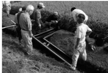
住民により設置される「水田魚道」
