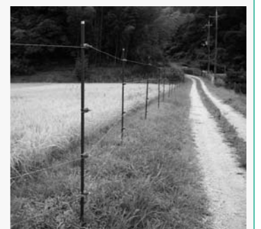
農道横に設置されている電気柵
