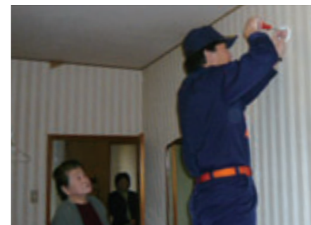
▲火災警報器を取り付ける消防団員
