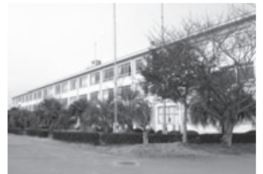
耐震補強工事を行う加西中学校北校舎 （昭和36年7月建築）
