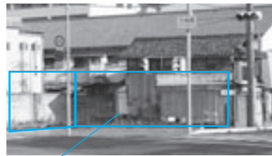
看板設置スペース
