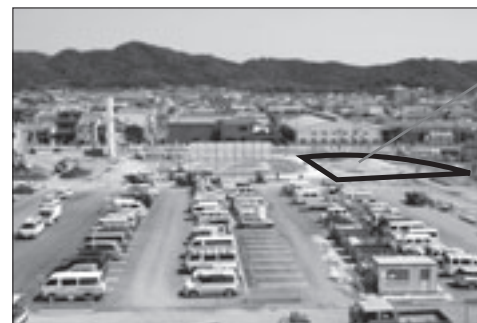
店舗屋上より北側撮影
