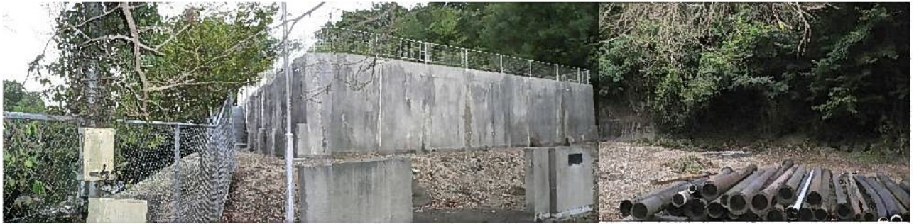
古坂第2配水池 全体外観
