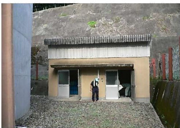
追加塩素注入設備室
