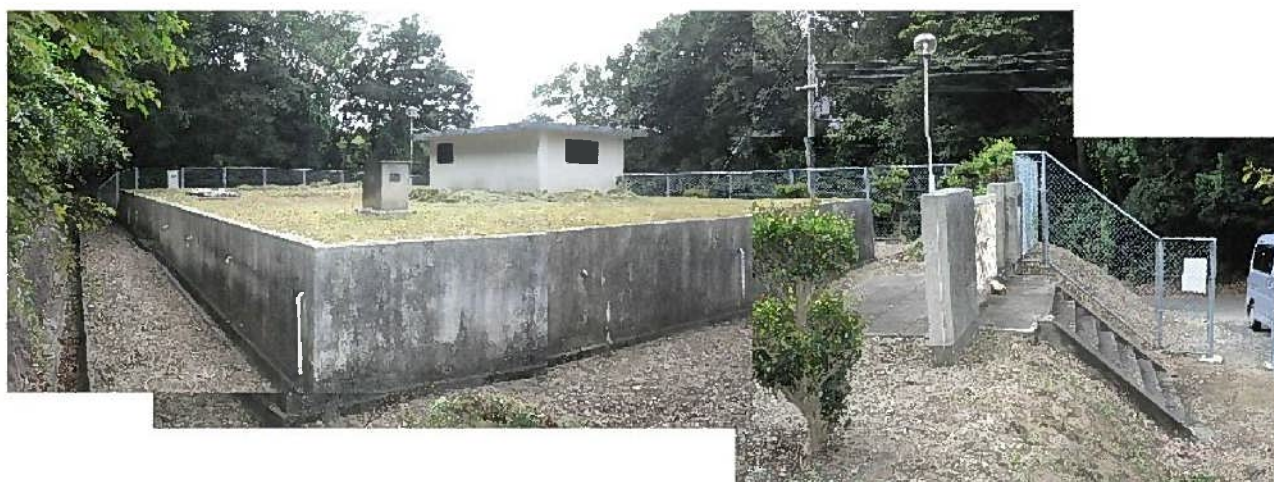
古坂第1配水池 全体外観
