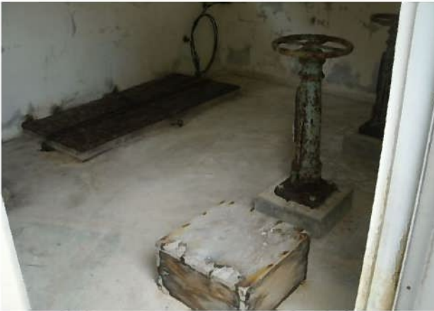
配水池上屋内部
