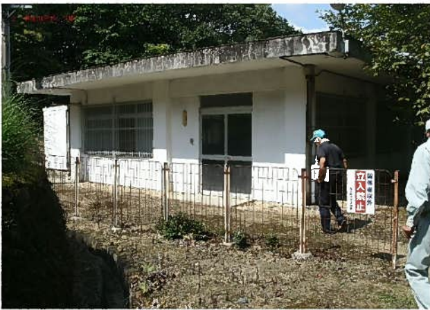
建屋（受水槽、制御室）
