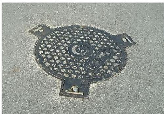
減圧弁室マンホール
