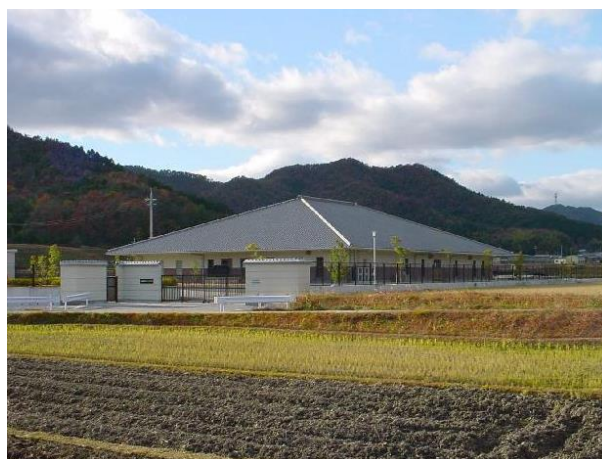
コミュニティプラント施設(加西北部処理場)
