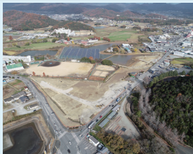
統合中学校建設工事
