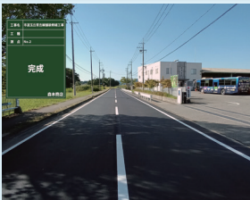
道路修繕工事
