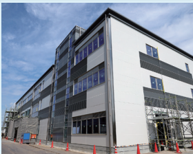
庁舎第二附属棟建設工事（こども家庭センター）
