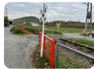
網引町内の危険踏切
