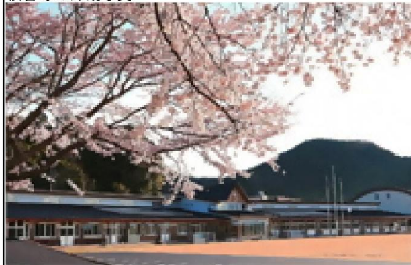
校舎等の外観写真
