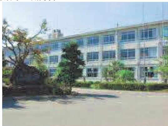
校舎等の外観写真
