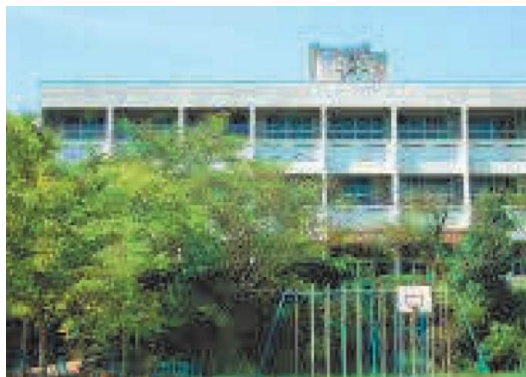
校舎等の外観写真
