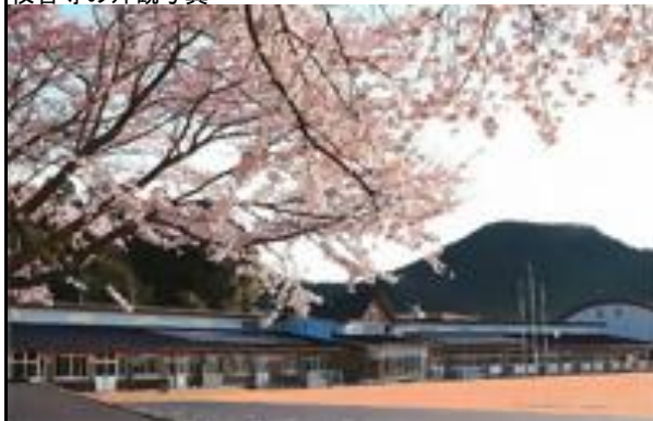
校舎等の外観写真
