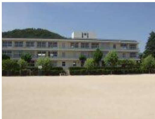
校舎等の外観写真
