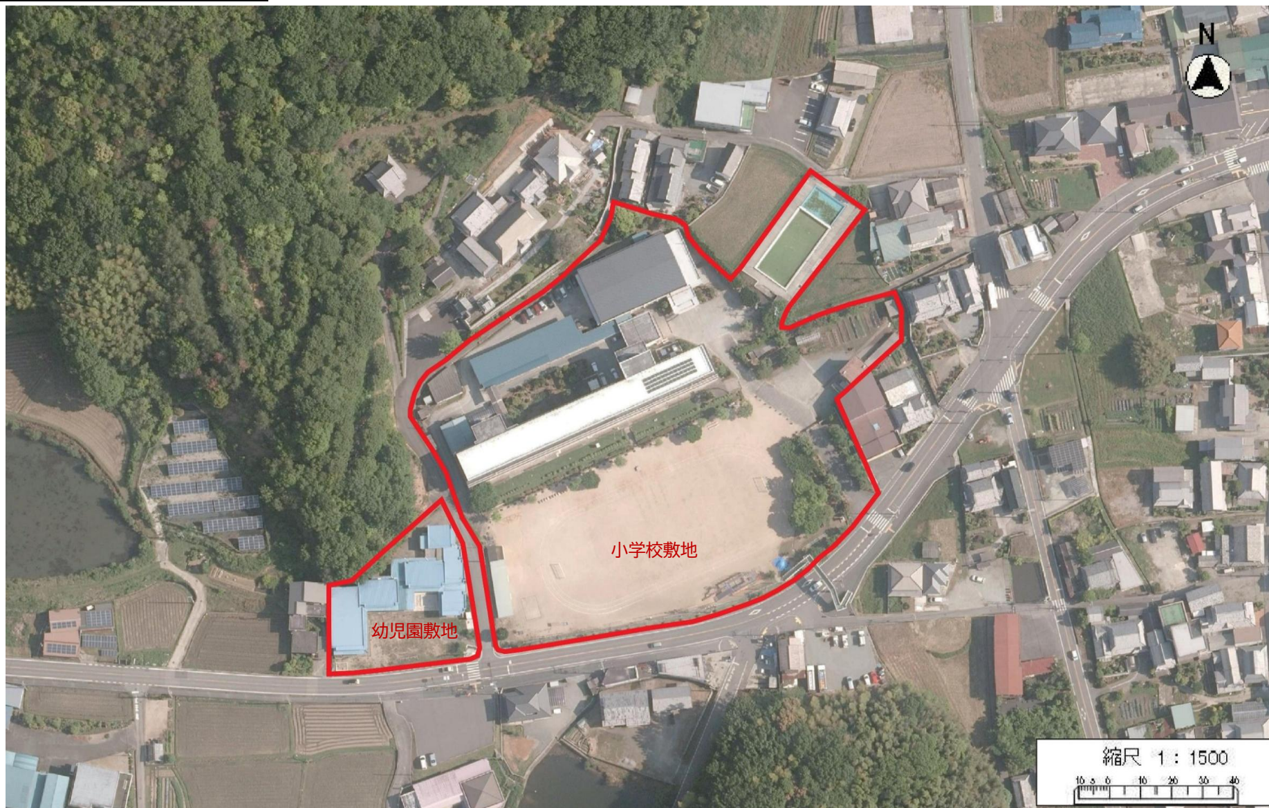
小学校敷地 航空写真
