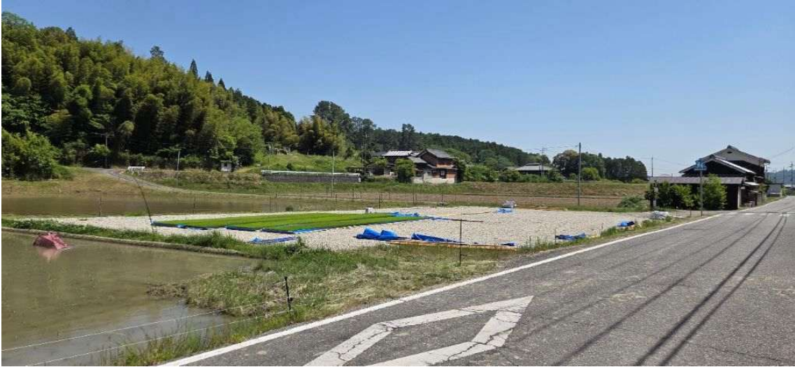
現場写真(北部世代交流館跡地)
