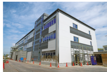
第二付属棟の建設工事の様子 (令和8年4月時点)
