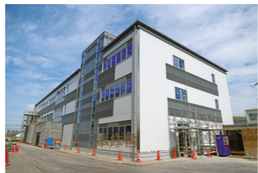
第二附属棟の建設工事の様子 (令和8年4月時点)
