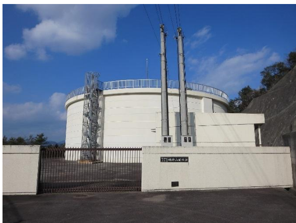
明神山配水池
