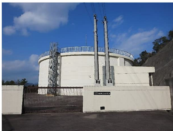
明神山配水池
